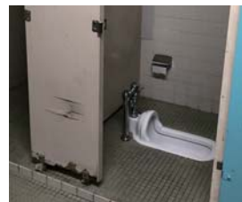
工事が始まった吹上中のトイレ(工事前の写真です)。
