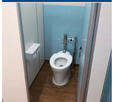
工事が完了した新町小学校のトイレ
